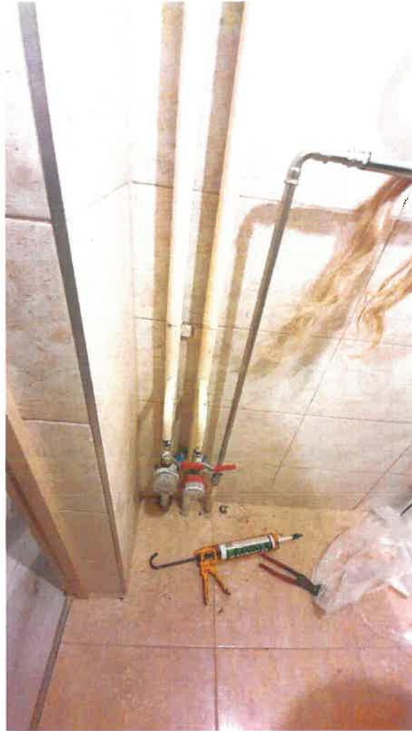
13 pav. Šalto ir karšto vandentiekio stovai butuose
