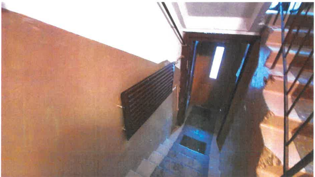
10 pav. Šildymo prietaisai laiptinėse
