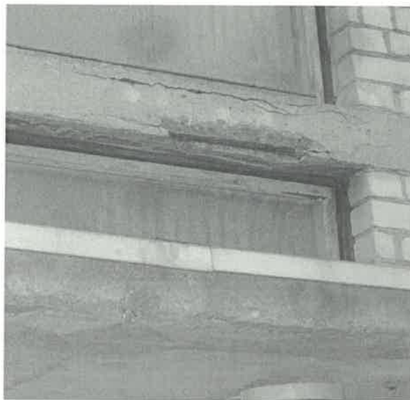
2 pav. Pažeistos sąramos fragmentas.
