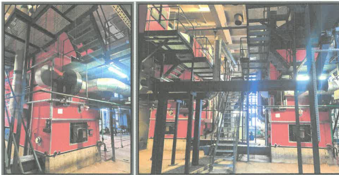
1 pav. Sumontuoti 3,1 MW ir 5 MW katilai
